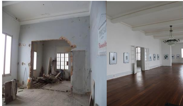
Imagen #5. Estado inicial del inmueble Casa Museo Tequendama a la izquierda. A la derecha la misma área luego de la restauración.
