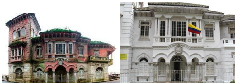
Imagen # 8. Avance de la obra de restauración y recuperación de la Casa Museo Tequendama
