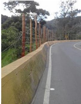
Imagen #7. Cerramiento de la playa del Salto de Tequendama.
